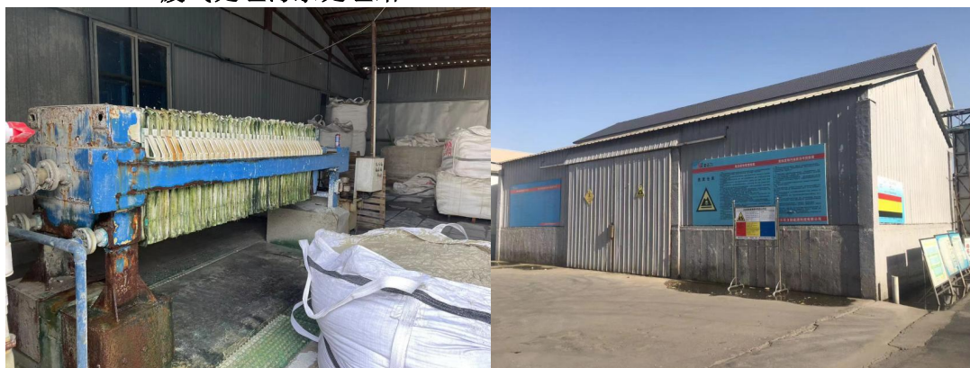
污泥压滤危废库
