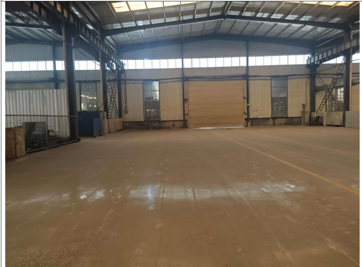
喷漆线拟建区
