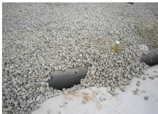
碎石导流层铺设照片
