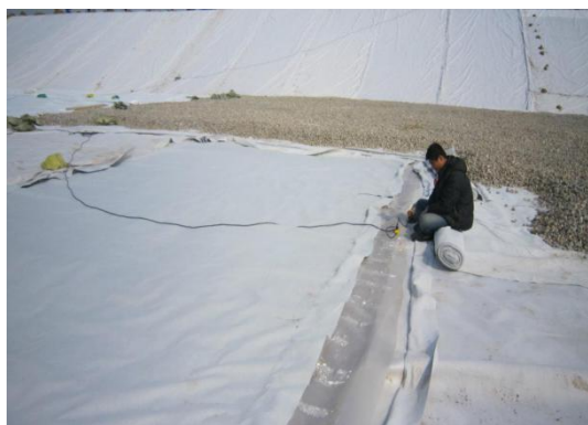
复合土工膜铺设照片
